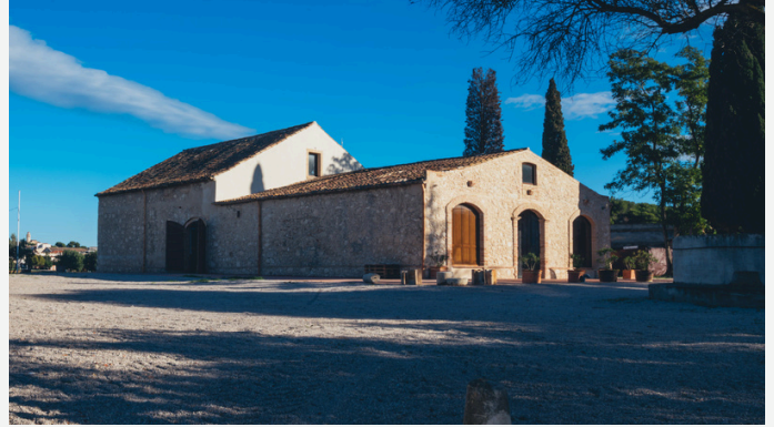
Imatge del celler del Moli de Vent al 2024, després de la rehabilitació
